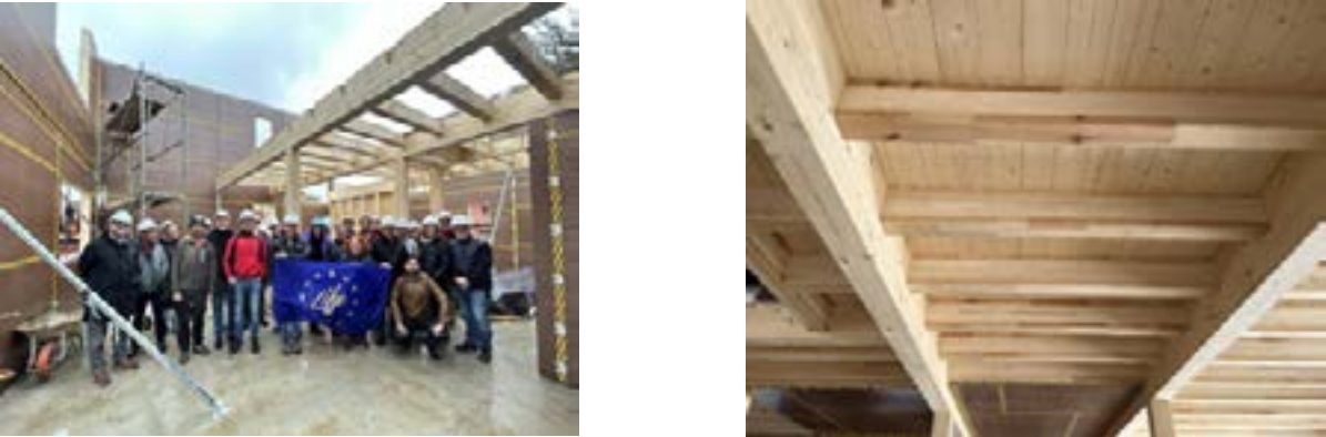
Figura 1. Visita a la obra del comité científico del Proyecto LIFE Wood For Future e IberoLAM, junto con familia propietaria, los montadores de MADERGIA, y el equipo técnico. Fuente: Bonsai Arquitectos. Figura 2. Tramo de forjado demostrador con vigas MCLam vistas en el estar-comedor de la vivienda de Ogjares. Fuente: Bonsai Arquitectos.
