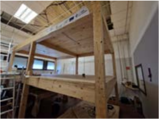
Figura 3: Fotografía del demostrador. Esqueleto estructural,
