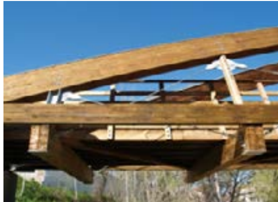
Figura 7. Péndolas y arriostramientos
