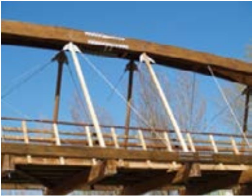
Figura 6. Unión rígida de los arcos.
