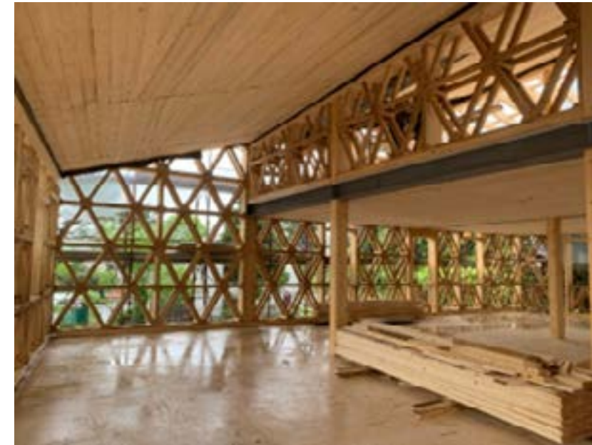
Figura 2. Edificio de tres plantas en fase de construcción en Padenghe sul Garda, Brescia.
