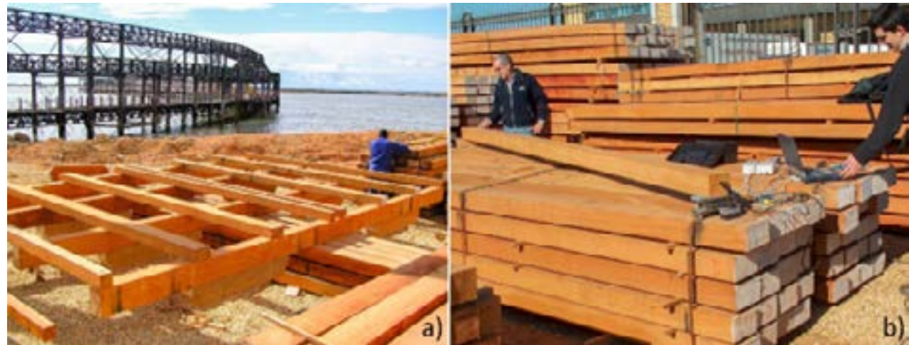
Figura 1. Intervención en el Muelle Cargadero de Mineral de Río Tinto (Huelva): a) estructura de madera nueva de elondo; b) evaluación de madera de elondo mediante técnicas no destructivas.
