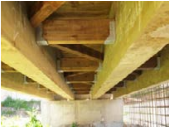
Figura 8. Vista inferior del tablero.
