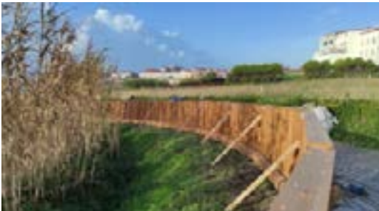
Figura 4. Trabajos de montaje. Cara Exterior
