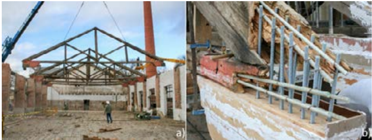
Figura 2. Intervención en el Real Taller de Aserrío de Valsaín (Segovia): a) desmontaje de cerchas de cubierta; b) reparación de pudriciones con barras de acero y poliéster con fibra de vidrio.
