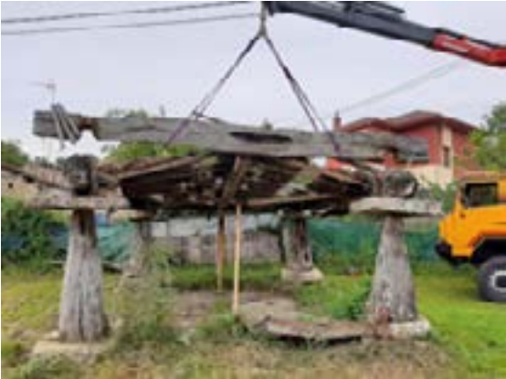
Figura 1. Desmontaje de uno de los hórreos
