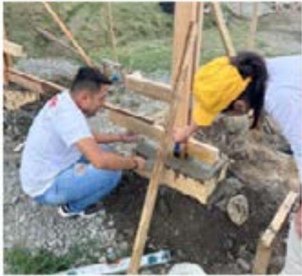
Figura 7. Anclaje de pórticos
