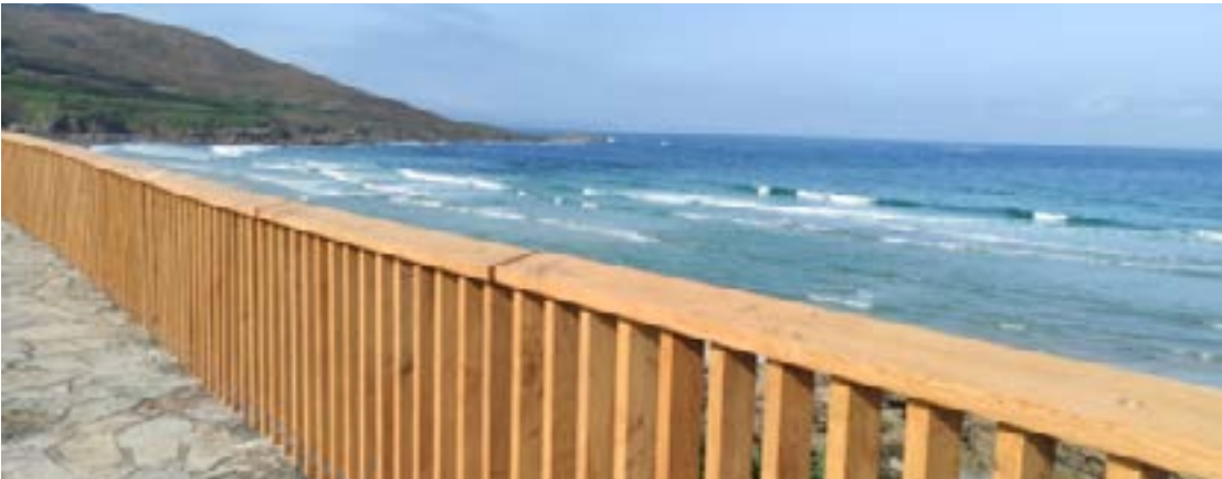
Figura 5. Módulos ya instalados
